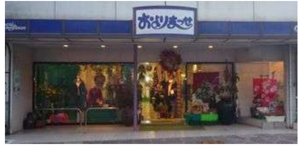
【ファサードの改善“アフター”】
